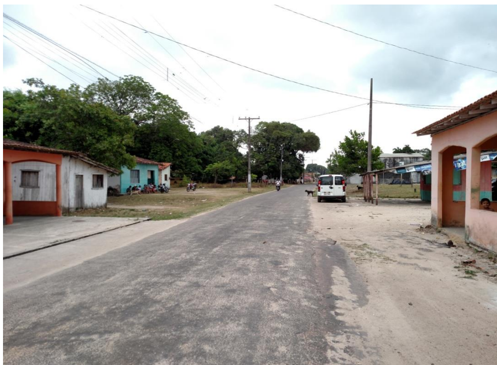
Figura 10: Estrada de acesso à Cachoeira (rua principal)
