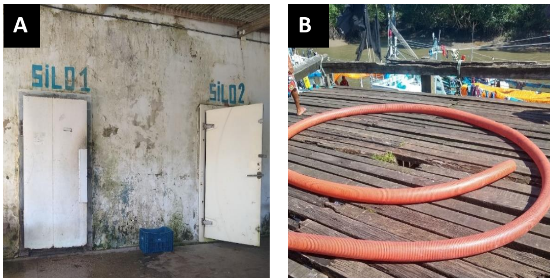
Figura 15: (a) Silos da fábrica; (b) Mangueira dos silos
